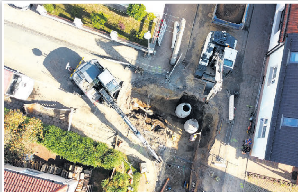
Sanierungsarbeiten in der Sankt-Jakobi-Straße in Hettstedt. Reparaturen am Kanalsystem sind sehr teuer.
