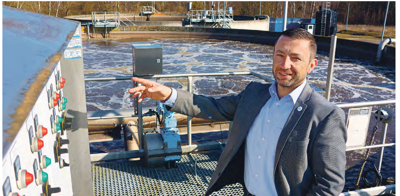
Im Belebungsbecken werden die Belüftungselemente erneuert. Der Verbandsgeschäftsführer Stephan Sterzik erhofft sich damit große Einsparungen beim Energieverbrauch.
