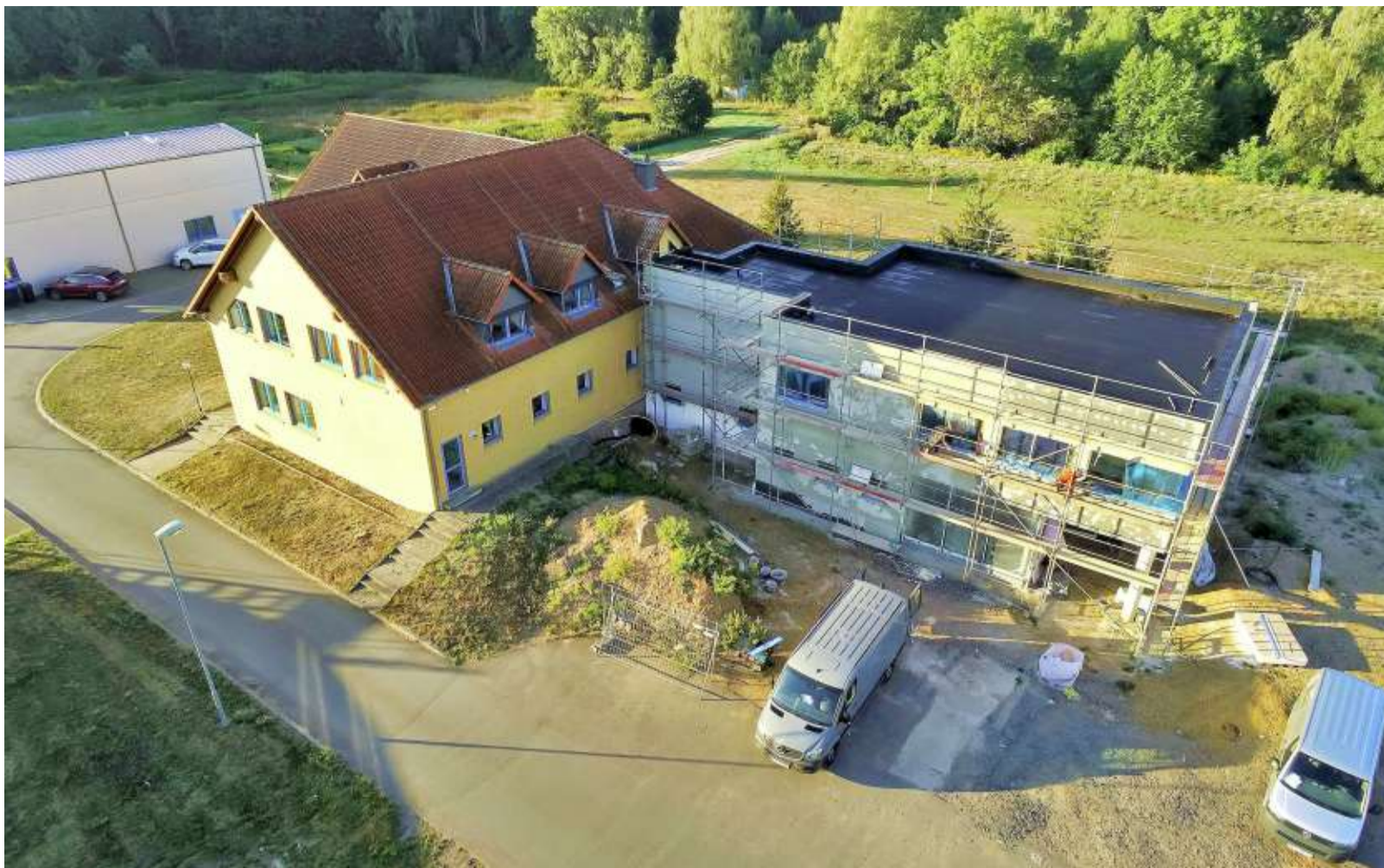
Der Anbau am Verwaltungsgebäude des Abwasserzweckverbands Wipper-Schlenze in Hettstedt ist in den vergangenen Monaten deutlich gewachsen. FOTO: SCHUMANN
